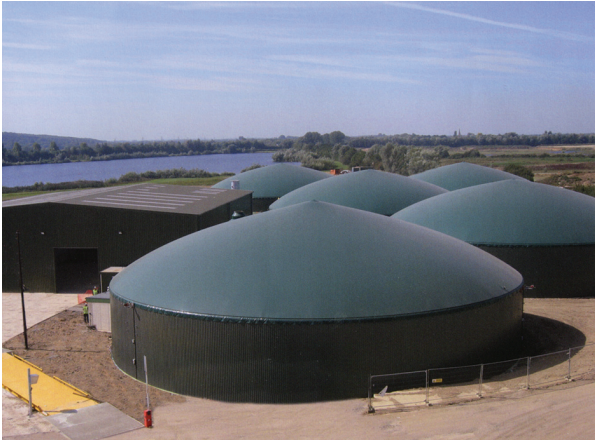
Wartet mit einer Leistung von 1 MW auf: In dem Anlagenpark im englischen Oxford werden organische Abfälle der Stadt zu Biogas verarbeitet
